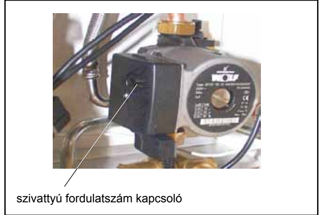
Ábra: a 3-fokozatú szivattyú fordulatszám kapcsolója
