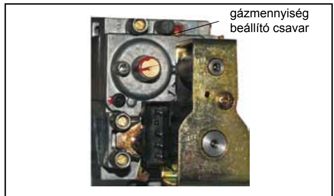
Ábra: a kombinált gázszelep
