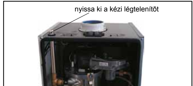
Ábra: kézi légtelenítő szelep
